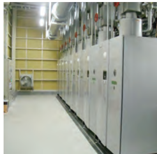
岡崎技術センター用に新設した小型ボイラー
