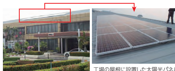
工場の屋根に設置した太陽光パネル
