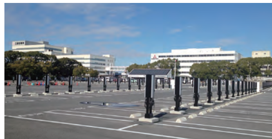
岡崎地区の社員駐車場に設置した普通充電器
