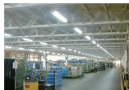
LED照明が導入された生産ライン
