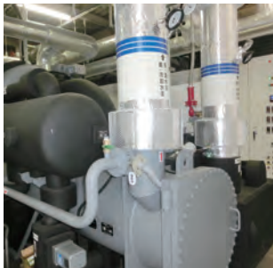
名古屋製作所で更新したターボ冷凍機
