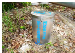
水質観測用井戸 (岡崎製作所)
