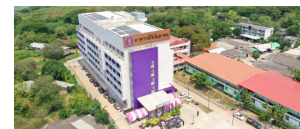
環境プロジェクト「Solar for Lives」 太陽光発電設備を設置した病院
