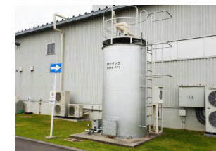
雨水貯留タンク（岡崎製作所）
