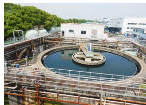
総合排水処理施設 (岡崎製作所)
