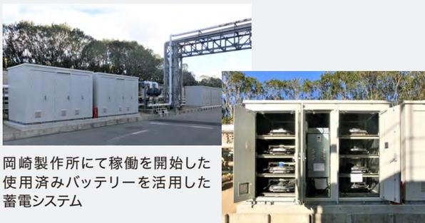
岡崎製作所にて稼働を開始した使用済みバッテリーを活用した蓄電システム
