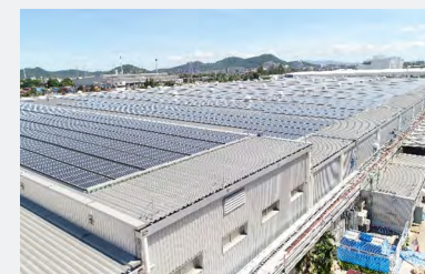
MMThで稼働を開始した大規模太陽光発電設備
