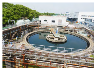
総合排水処理施設 (岡崎製作所)
