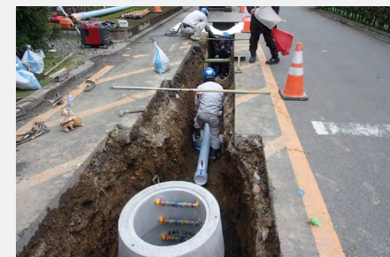
工場排水用の排水管の埋設工事 (京都製作所)
