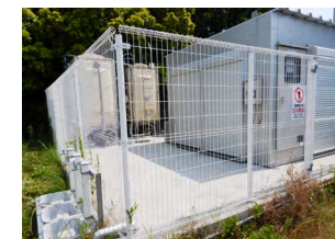
地下水膜ろ過設備（岡崎製作所）
