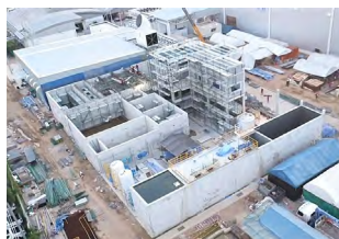
建設中の排水リサイクルプラント (タイ)
