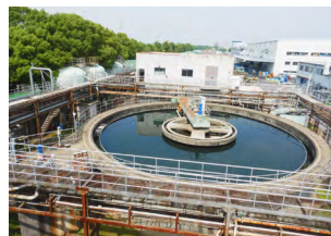
総合排水処理施設 (岡崎製作所)
