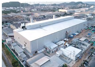
タイで現在建設中の新塗装工場(MMTh)
