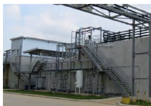
工業用水排水処理場 (インドネシア)
