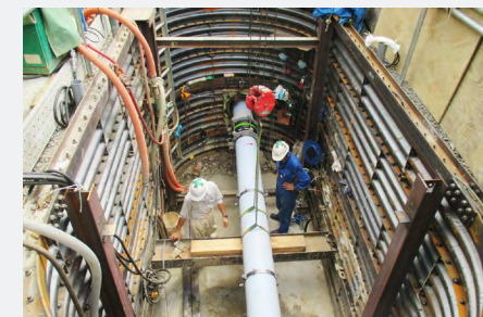
汚水専用の排水管の埋設工事(京都製作所)
