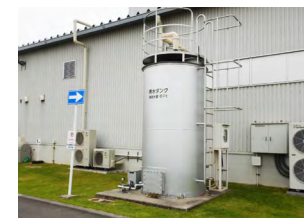
雨水貯留タンク（岡崎製作所）
