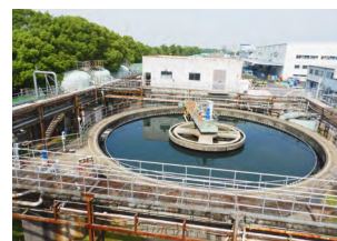
総合排水処理施設(岡崎製作所)
