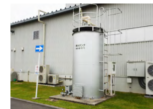
雨水貯留タンク（岡崎製作所）
