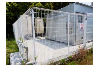
地下水膜ろ過設備（岡崎製作所）
