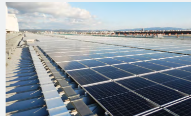
大規模太陽光発電設備
