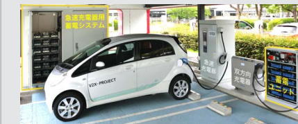
使用済みバッテリーリユース実証設備
