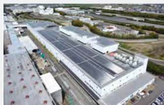
岡崎製作所 塗装工場全景
