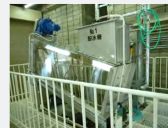
新たに導入したスクリー式汚泥脱水装置
