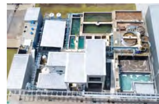
排水リサイクルプラント (MMTh)
