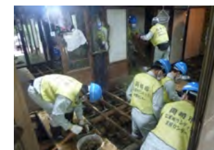
床下の泥をかき出す作業
