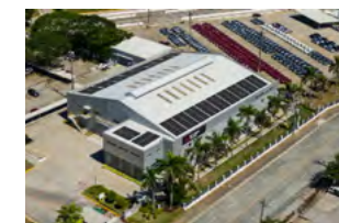
MMPCの工場屋根に太陽光パネルを設置
