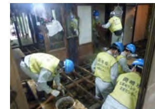
床下の泥をかき出す作業
