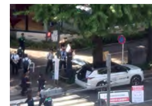
給電により信号機を復旧している様子
