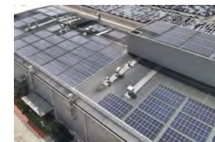
MMKIの工場屋根に太陽光パネルを設置
