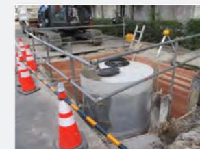
雨水の排水経路に設置したマンホール型油水分離ます
