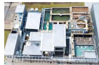
排水リサイクルプラント (MMTh)
