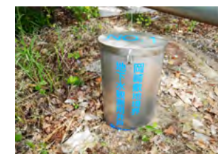
水質観測用井戸 (岡崎製作所)
