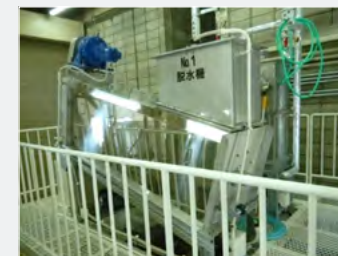
新たに導入したスクリー式汚泥脱水装置
