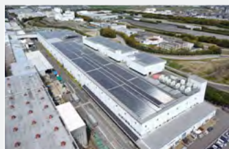
岡崎製作所 塗装工場全景
