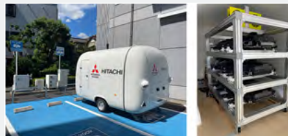
左：バッテリーキューブから給電している様子
