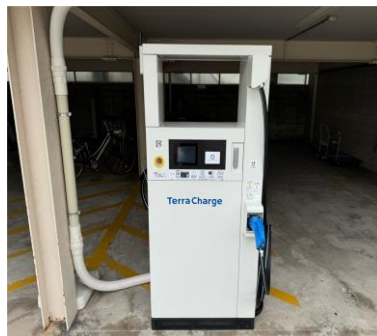
設置した急速充電器
