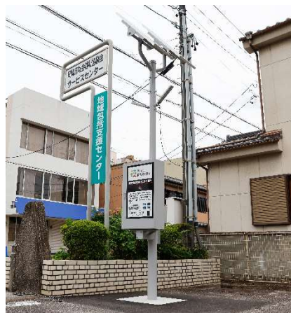
設置された街路灯
