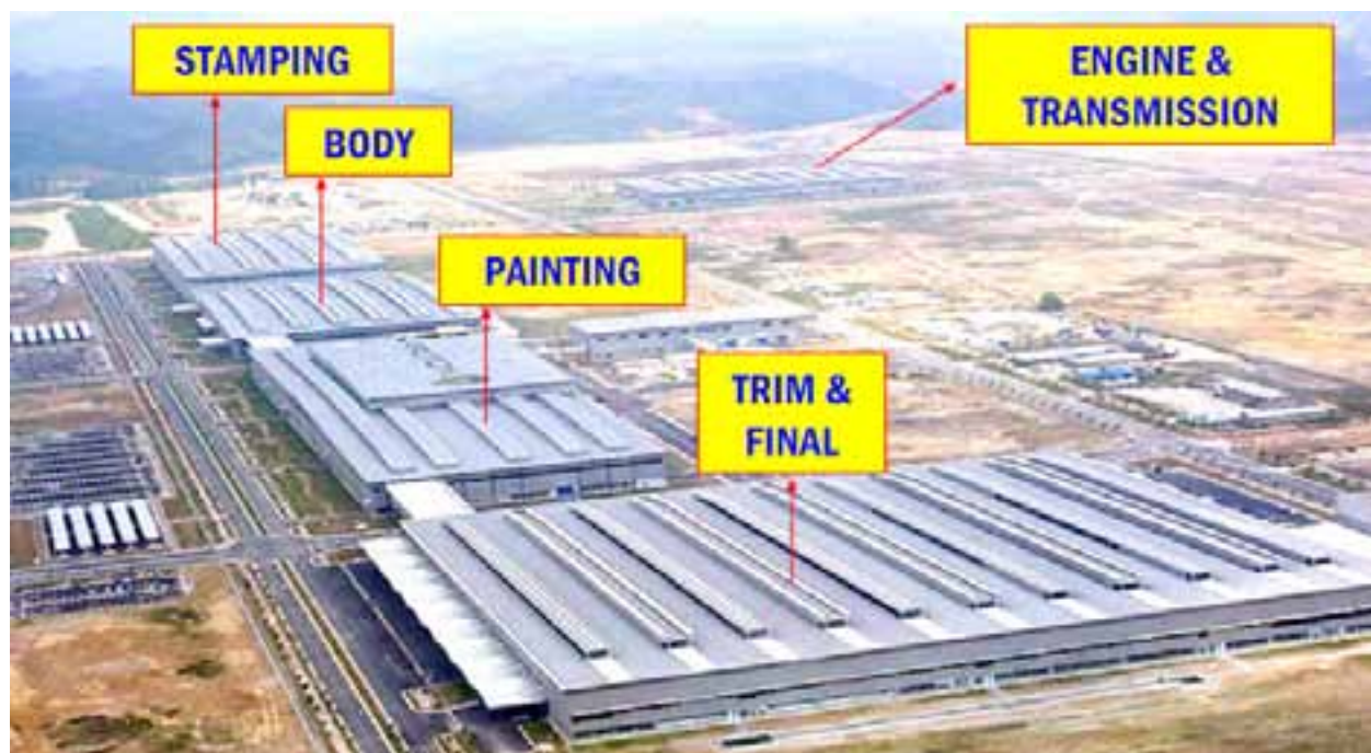
プロトン社 タンジュンマリム工場
